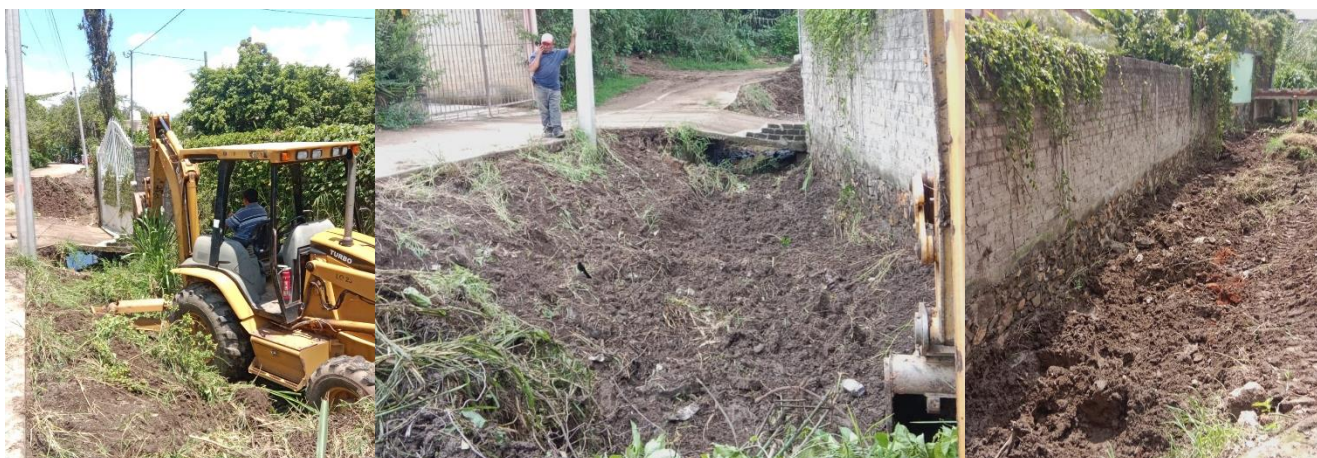
DESAZOLVES DE RÍOS, CALLES/CAMINOS Y CUNETAS
