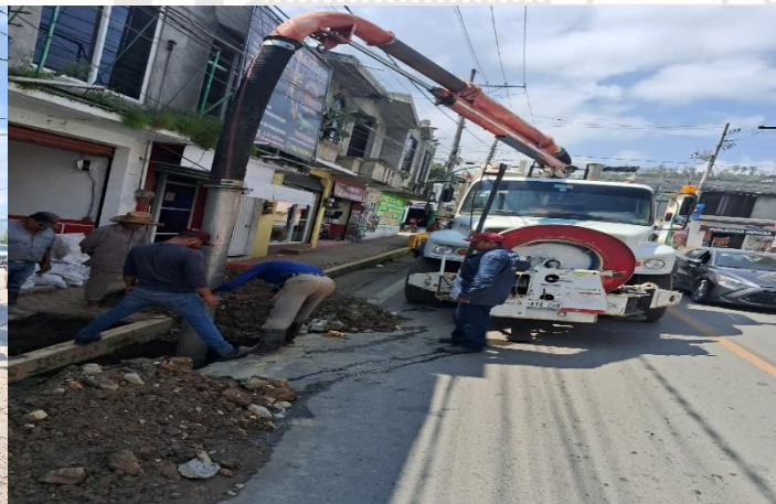
MANTENIMIENTO A LA INFRAESTRUCTURA DE DRENAJE Y ALCANTARILLADO CON CAMIÓN VACTOR
