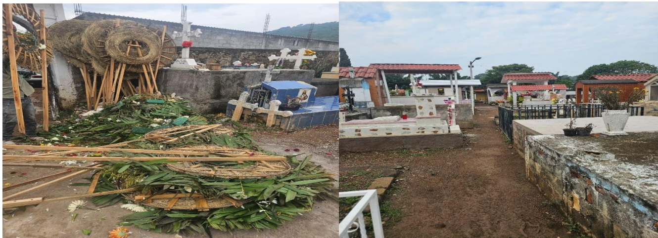
MANTENIMIENTO AL PANTEON SANTO DOMINGO
