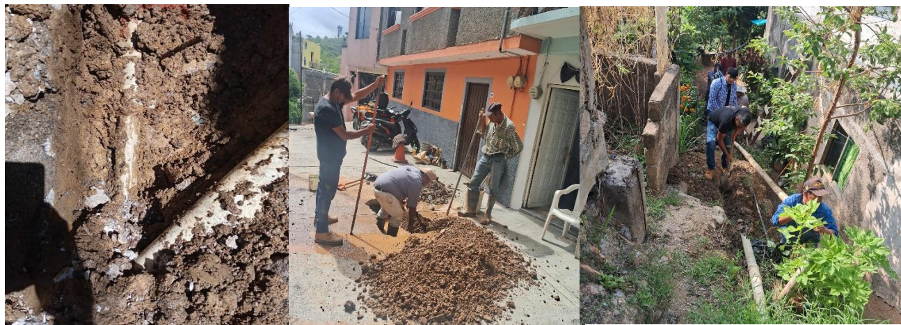
REPARACIÓN DE FUGAS EN TOMAS DOMICILIARIAS, DE LA RED DE CONDUCCIÓN Y DISTRIBUCIÓN DE AGUA POTABLE
