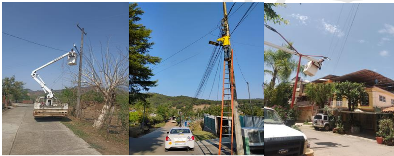
SUSTITUCIÓN DE LAS LUMINARIAS DE ALUMBRADO PÚBLICO
