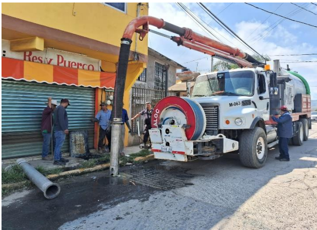
MANTENIMIENTO A LA INFRAESTRUCTURA DE DRENAJE Y ALCANTARILLADO CON CAMIÓN VACTOR
