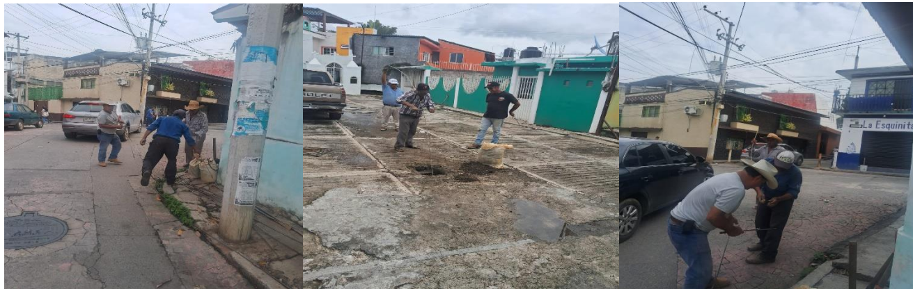
MANTENIMIENTOS MANUALES A LA INFRAESTRUCTURA DE DRENAJE Y ALCANTARILLADO
