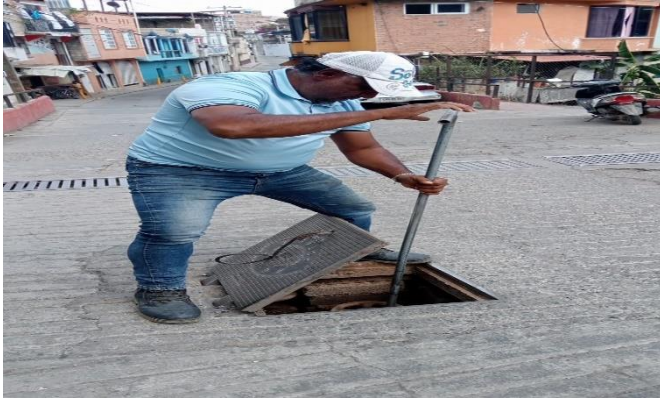
VERIFICACIÓN DE LA LÍNEA DE CONDUCCIÓN (VÁLVULAS)
