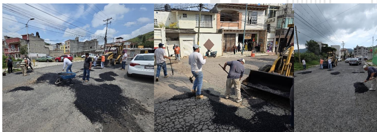
BACHEO CON MEZCLA ASFÁLTICA
