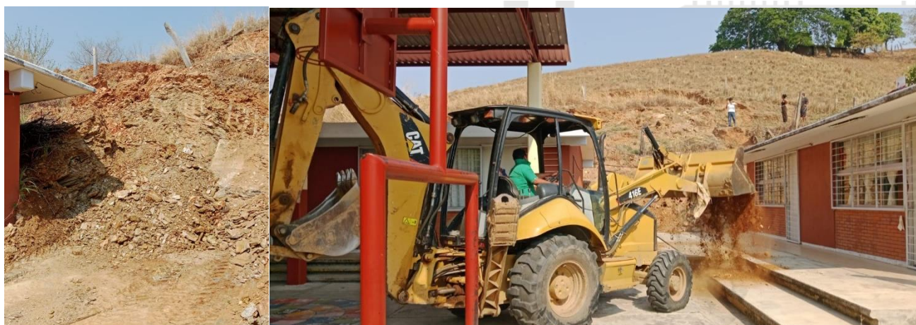
DESAZOLVES DE RÍOS, CALLES/CAMINOS Y CUNETAS
