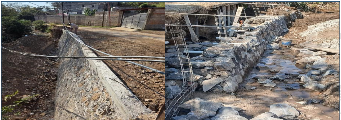
REHABILITACIÓN DE VIALIDADES
