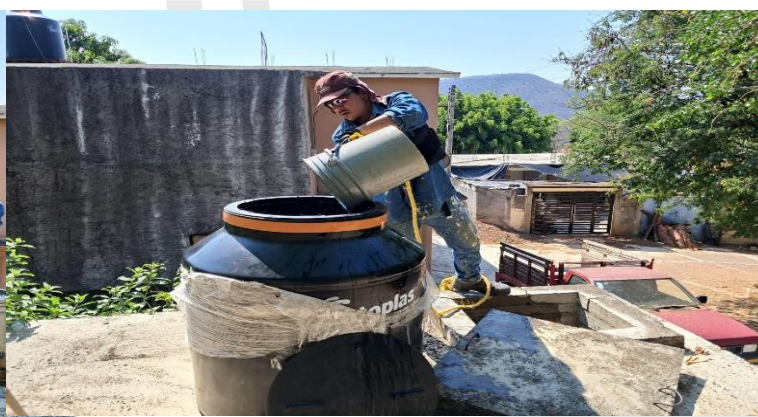
PROCESO DE CLORACIÓN EN LAS PRINCIPALES FUENTES DE ABASTECIMIENTO
