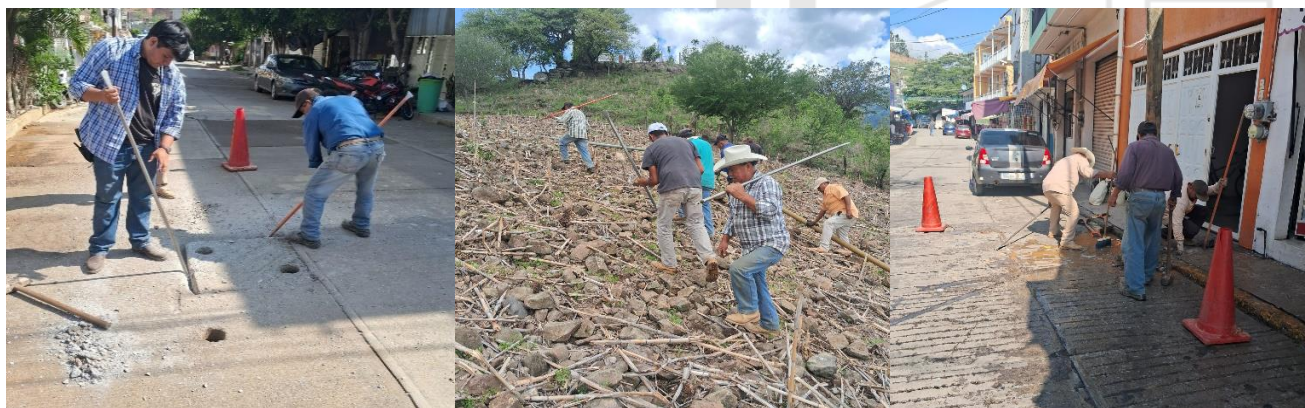
VERIFICACIÓN DE LA LÍNEA DE CONDUCCIÓN Y DISTRIBUCIÓN DE AGUA POTABLE.
