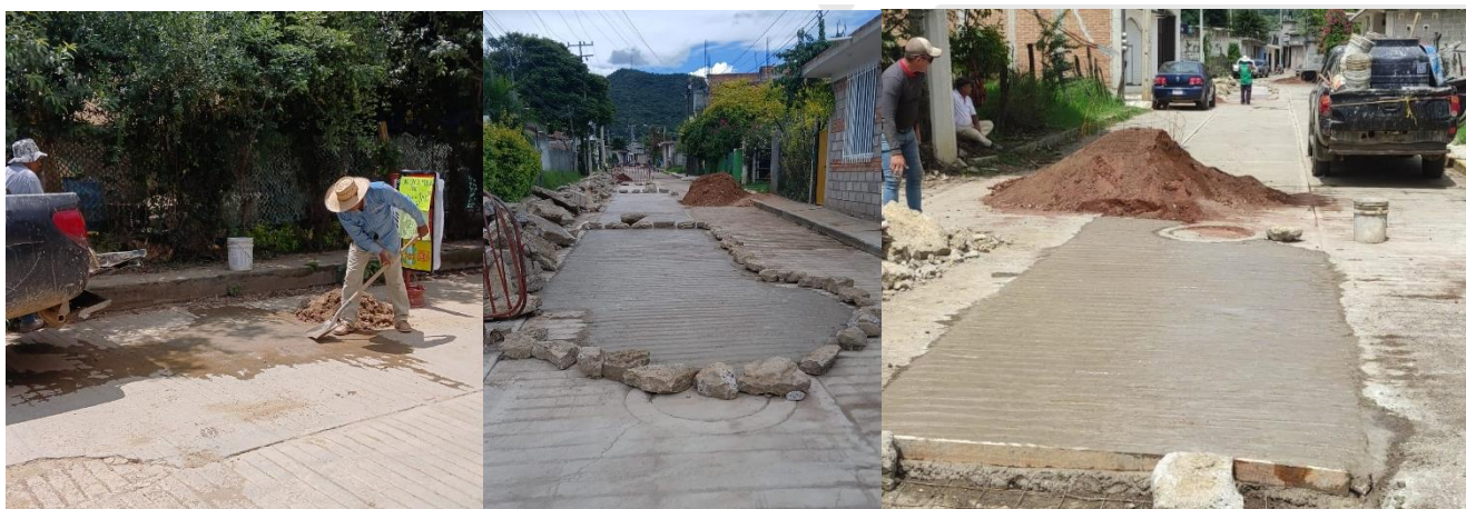
BACHEO CON CONCRETO HIDRÁULICO
