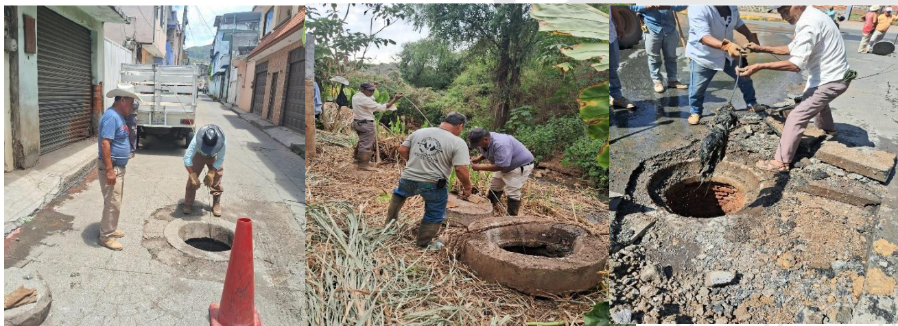
DESAZOLVE DE DRENAJE
