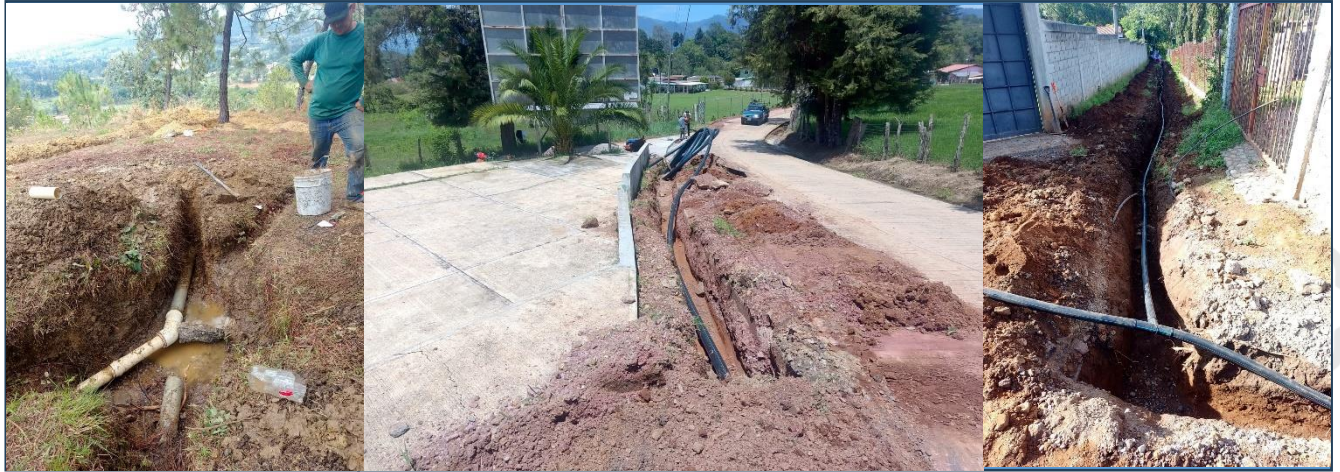
CONSTRUCCIÓN DE INFRAESTRUCTURA PARA AGUA POTABLE
