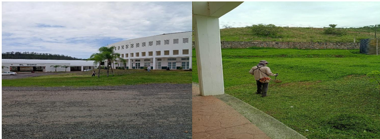
MANTENIMIENTO EN EL RECINTO FERIA
